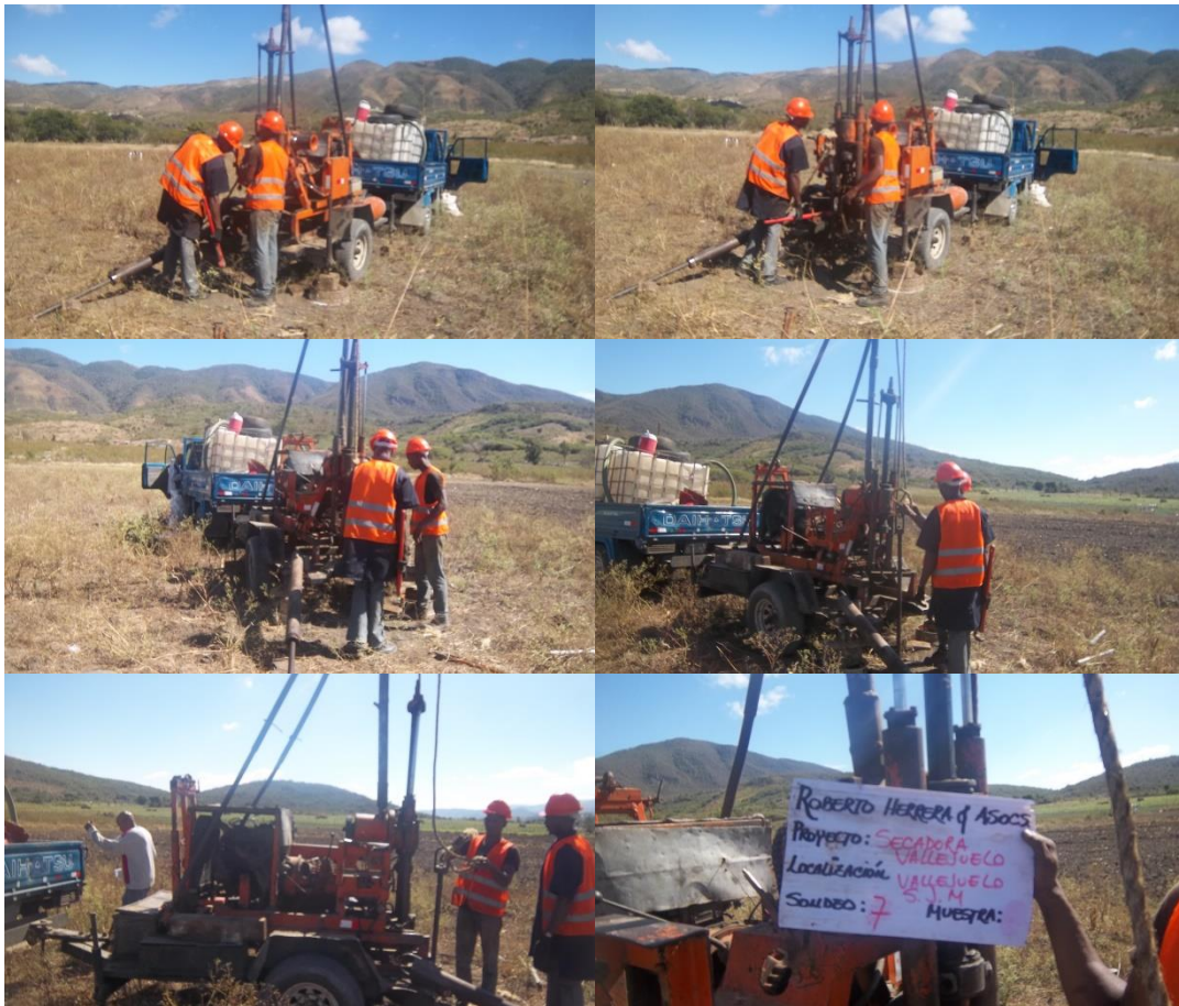
Máquina Posicionada Para la Realización de los Sondeos.
