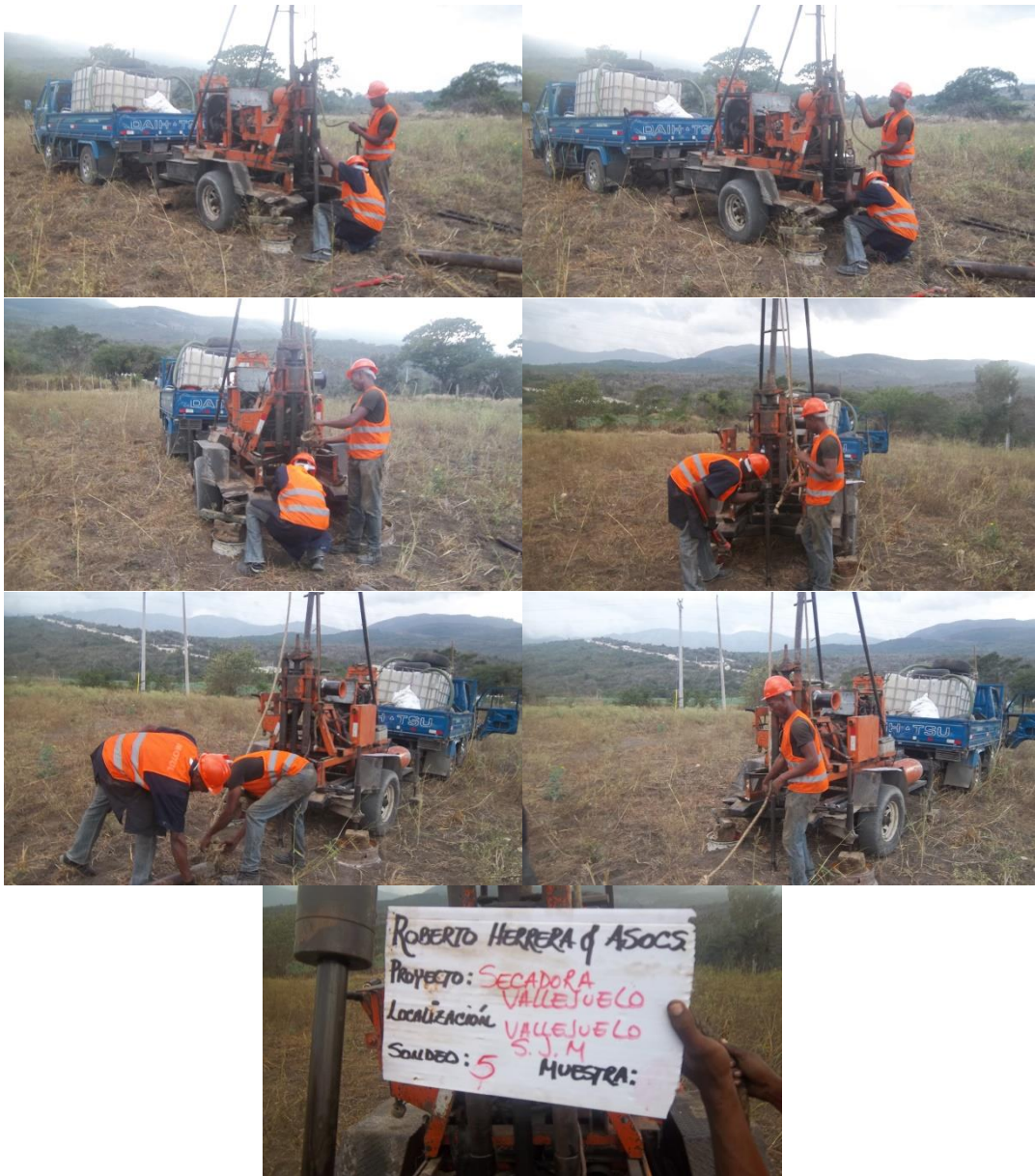
Máquina Posicionada Para la Realización de los Sondeos.
